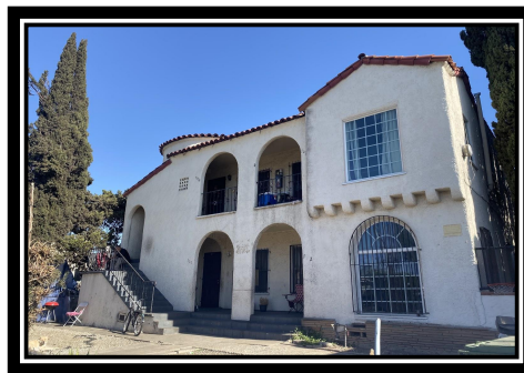
Colaboración entre CLT-CDC en LA
